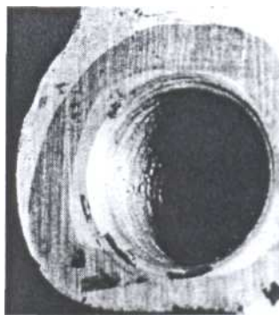
Rys. 59. Zerwany gwint w otworze. Ewentualna naprawa przez tulejowanie lub stosowanie specjalnych wkładów naprawczych [3, s. 197].
